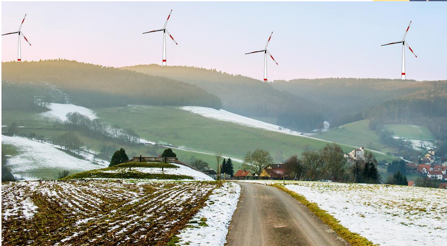
Unter - Sensbach Wasserwerk, Windpark Sensbacher - Höhe
